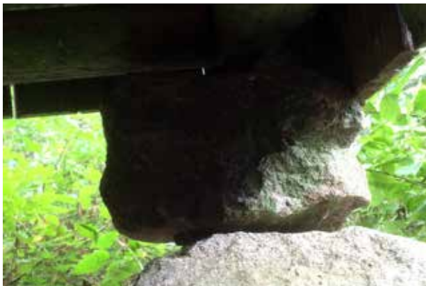
Rakennuksen nurkkakivien korot on tarkistettava.
