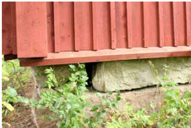
Päärakennuksen sokkelikivet
