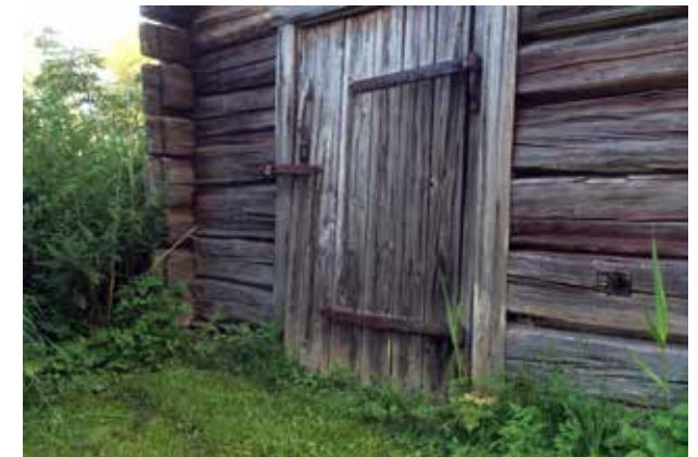
Maanpinta edellyttää muotoilua, perustuskivet oikaisun ja alin hirsikerta korjausta.
