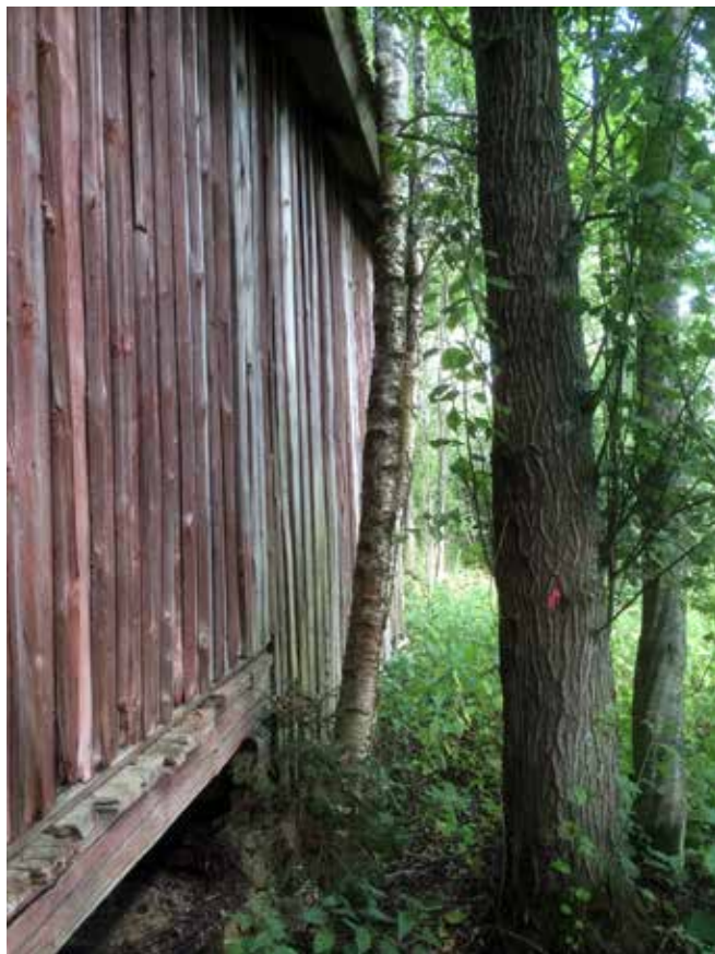
Rakennuksen liian lähellä kasvava puusto rasittaa rakennusta.
