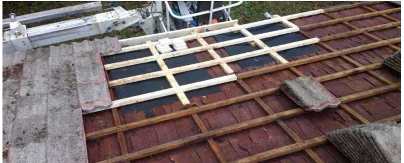
Periaate aluskatteen ja kattotiilien tuulettumisesta. Kuvassa aluskatteena toimiva vanha pärekatto on puhdistettu ja korjattu paikallisesti bitumikermillä. Lahovaurioituneet ruoteet on uusittu ja vanhat tiilet ladottu uudelleen.
