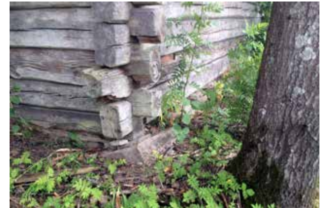
Pajan nurkkakivi on liikkunut puun juurien voimasta.
