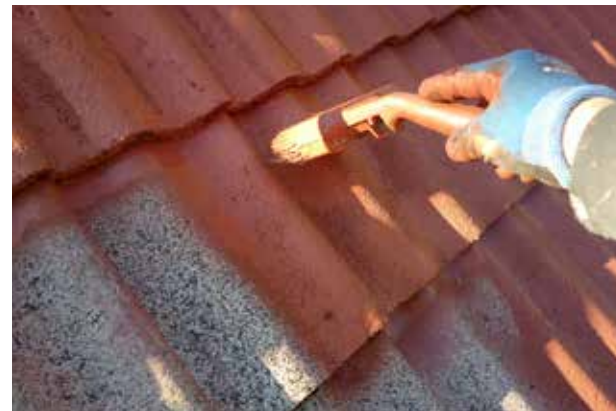
Betonitiilikaton uudelleen maalaus parantaa katon kuivana ja puhtaana pysymistä.
