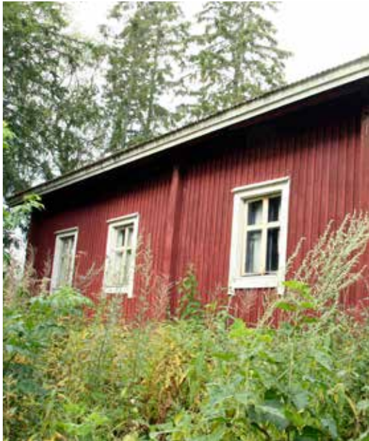
1. Maanpinnan kohoaminen aiheuttaa kosteusrasituksen kuistin rakenteille. 2. Ulkovuorauksen irronneet rimat. 3. ja 4. Julkisivu kaakkoon. Rakennuksen ulkovuoraus on yleisesti hyvässä kunnossa.
