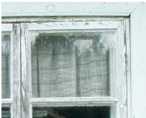
Esimerkki ikkunasta, jonka toimenpiteenä on huoltomaalaus.
