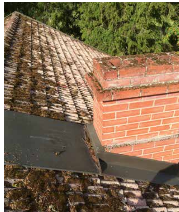
Piippujen pellitykset täytyy tarkistaa.
